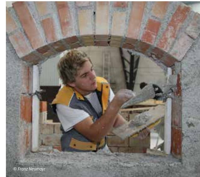
1989 eröffnete Salzburgs Bauwirtschaft den Lehrbauhof, ein in ganz Österreich geschätztes Aus- und Weiterbildungszentrum für die Bauwirtschaft.
